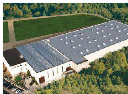
● Завод в Силс (Испания)
