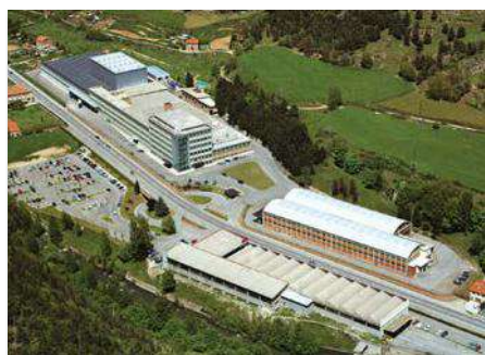
● Производственный комплекс в Риполе (Испания)
