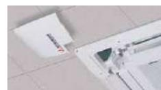
Система беспроводной связи монтируется простой установкой инфракрасного приемника в разъем в углу панели.
